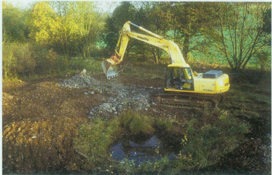
Abb. 2. Der durch die Naturschutzstiftung „Papilio“ bereitgestellte Kettenbagger bei den Arbeiten im Steinbruch Altenbrunslar
