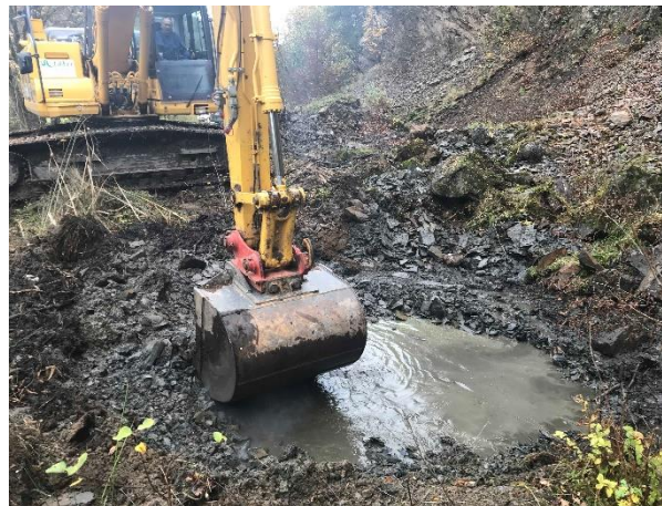
Arbeiten im Steinbruch Schmittlotheim.
