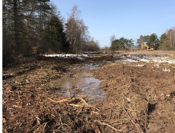
Flächen nach dem Einsatz des Forstmulchers.
