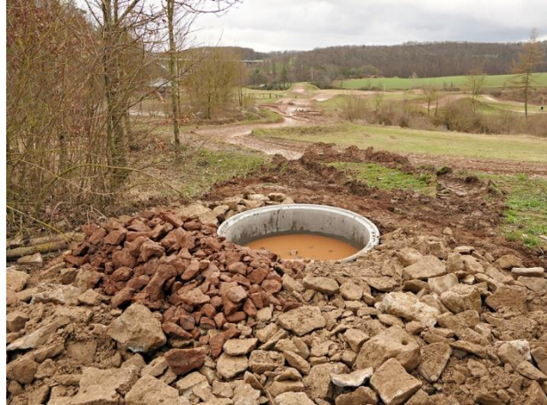
Eingebautes Kleingewässer mit Steinschüttung als Landlebensraum.
