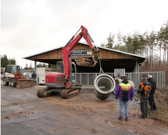
Transport eines Betonrings zum Einsatzort. 25.02.2023.
