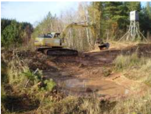
Bagger bei der Anlage von Amphibiengewässern
